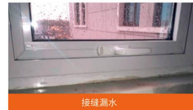
由于填充材料、工艺选择不合理导致的接缝密封失效渗水
